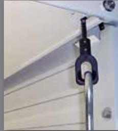
Grâce à la manoeuvre de secours, vous pourrez manoeuvrer la porte même en cas de coupure de courant.
