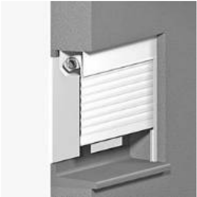
Sous le linteau vers l'intérieur
